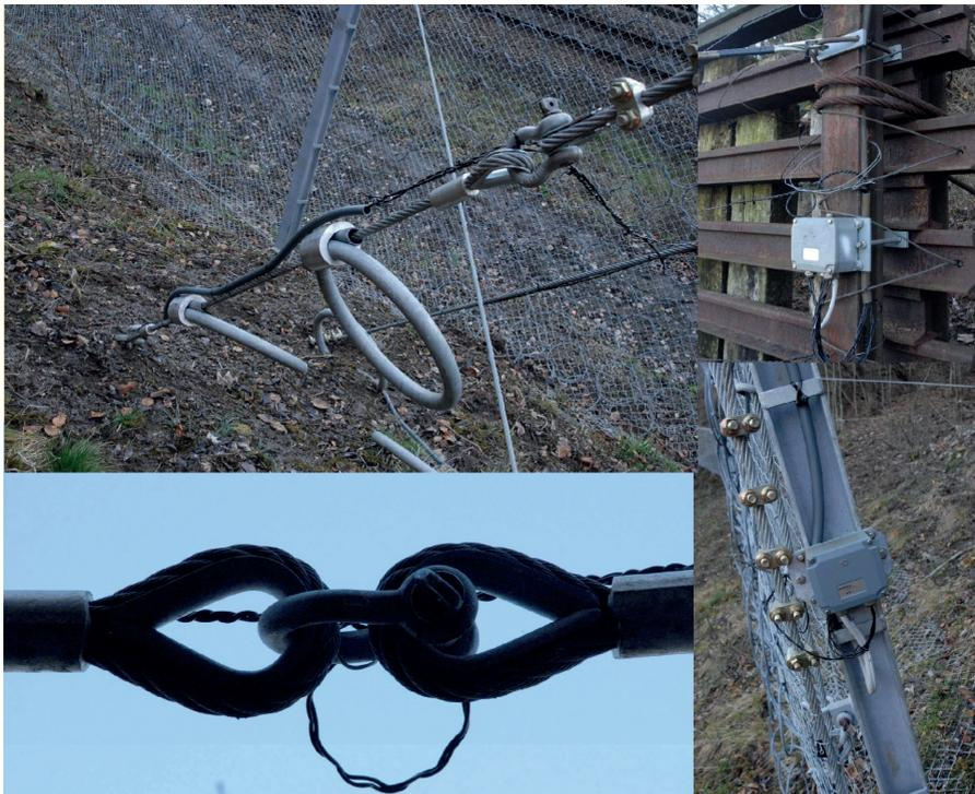
Abbildung 3: Elektrische Überwachung von Schutzbauwerken. Die in den Bremsen oder im Bauwerk eingebauten Drähte reißen im Überlastfall und leiten ein Signal an die Zugsleitzentrale.
