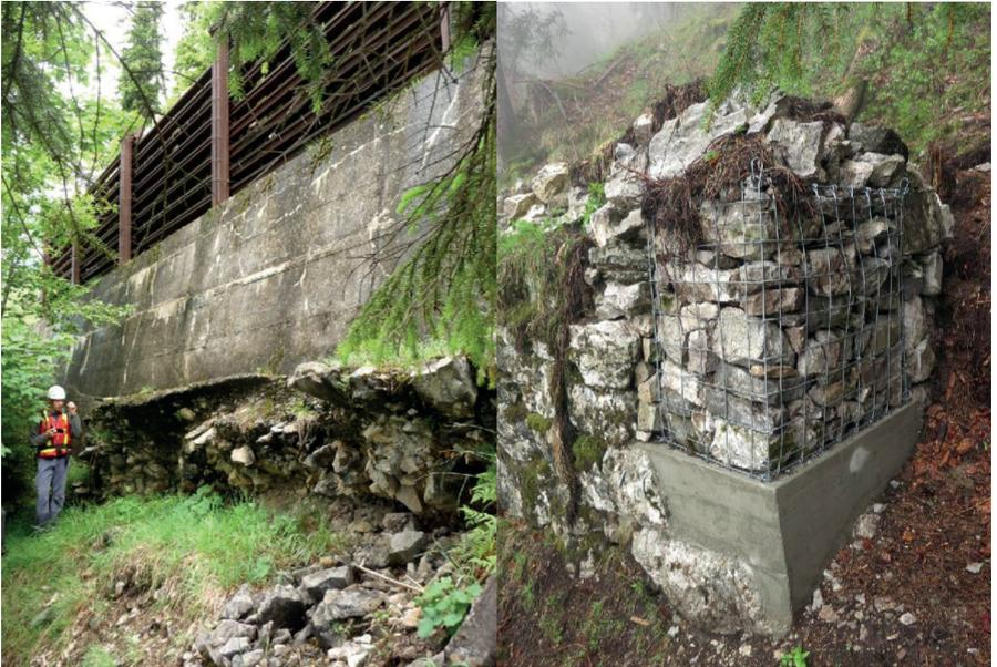
Abbildung 4: Die Lage der bestehenden Schutzbauten wird im Gelände mittels GPS erfasst, der Zustand des Bauwerks wird mittels visueller Kontrolle durch Fachleute beurteilt. Das Fundament dieser Betonmauer muss gesichert werden. (links). Diese Blocksteinmauer wurde mit armiertem Ortsbetonfundament und Drahtsteinkorb aufgrund der Zustandsbeurteilung instand gestellt(rechts).
