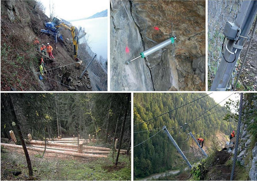
Abbildung 5: Das integrale Naturgefahrenmanagement der BLS Netz AG beinhaltet (von oben links im Uhrzeigersinn): Instandhaltung und Instandsetzung von bestehenden Bauwerken, Überwachung von instabilen Felspartien, Überwachung von bestehenden Schutzbauwerken, waldbauliche Massnahmen sowie die punktuelle Ergänzung mit neuen Schutzmassnahmen.
