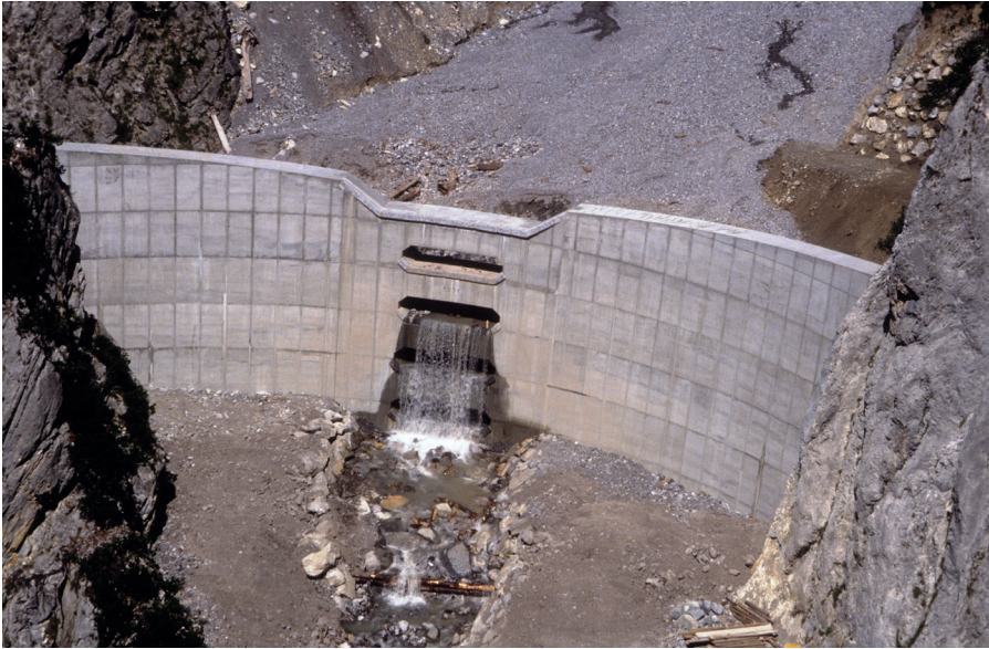
Abbildung 3: Die 17 Meter hohe kronengeschlossene großdolige Bogensperre.
