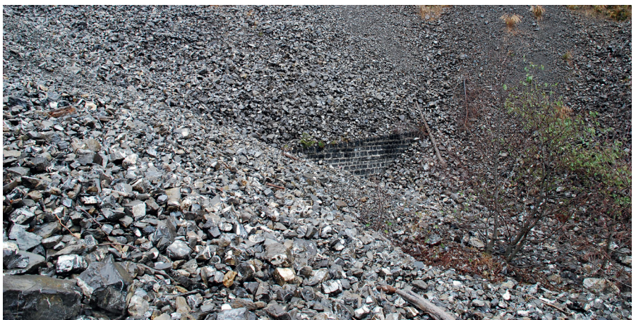
Abbildung 1: Sperrung V im Lammbach
