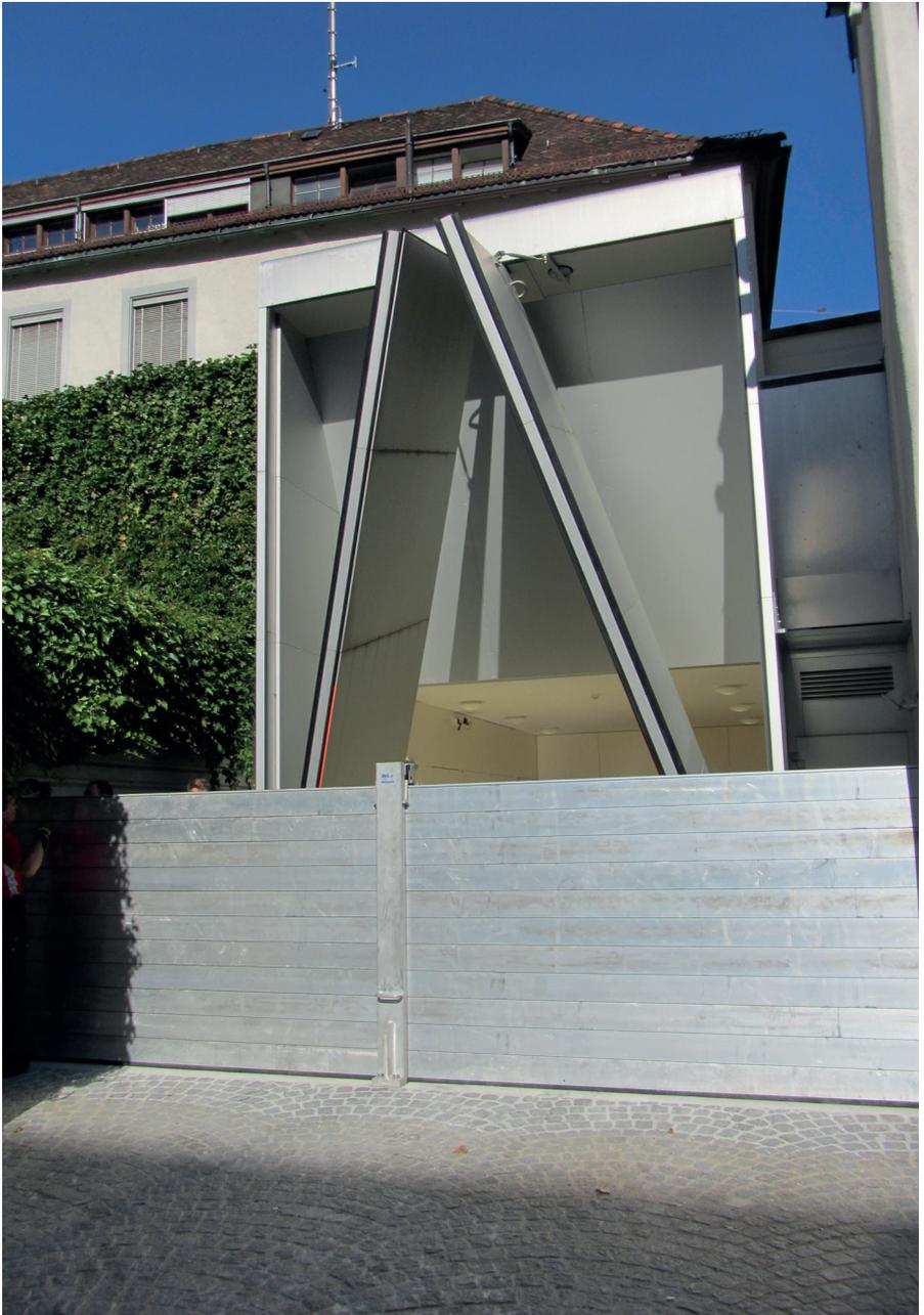
Abbildung 5: Das eingebaute Dambalkensystem vor dem Tor der KNZ
