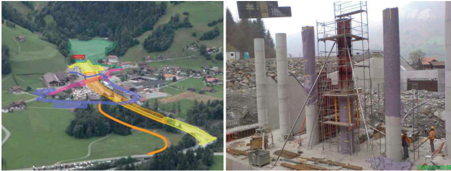
Abbildung 2: Linkes Bild: Hochwasserschutzmassnahmen Chiene in Kien - Übersicht Gesamtkonzept mit Rückhaltebecken (grün), Gerinneaufweitung und –stabilisierung mittels Blocksteinschwellen (orange), Blocksteinrampen (gelb), neue Dorfbrücke (pink), Damm Überlastkorridor (orange Linie). Rechtes Bild: Bau des vorgelagerten Schwemmholzrechens (2010) mit dahinterliegender Geschiebesperre.
