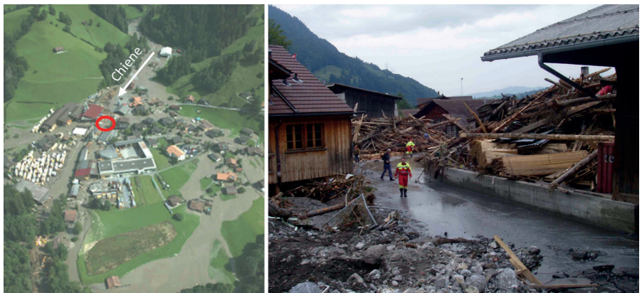
Abbildung 1: Aufnahmen vom Chiene-Hochwasser 2005 im Dorf Kien. Linkes Bild: Luftaufnahme vom Dorf Kien mit dem Standort der Dorfbrücke (roter Kreis). Rechtes Bild: Holzablagerungen bei der Dorfbrücke nach dem Hochwasser.
