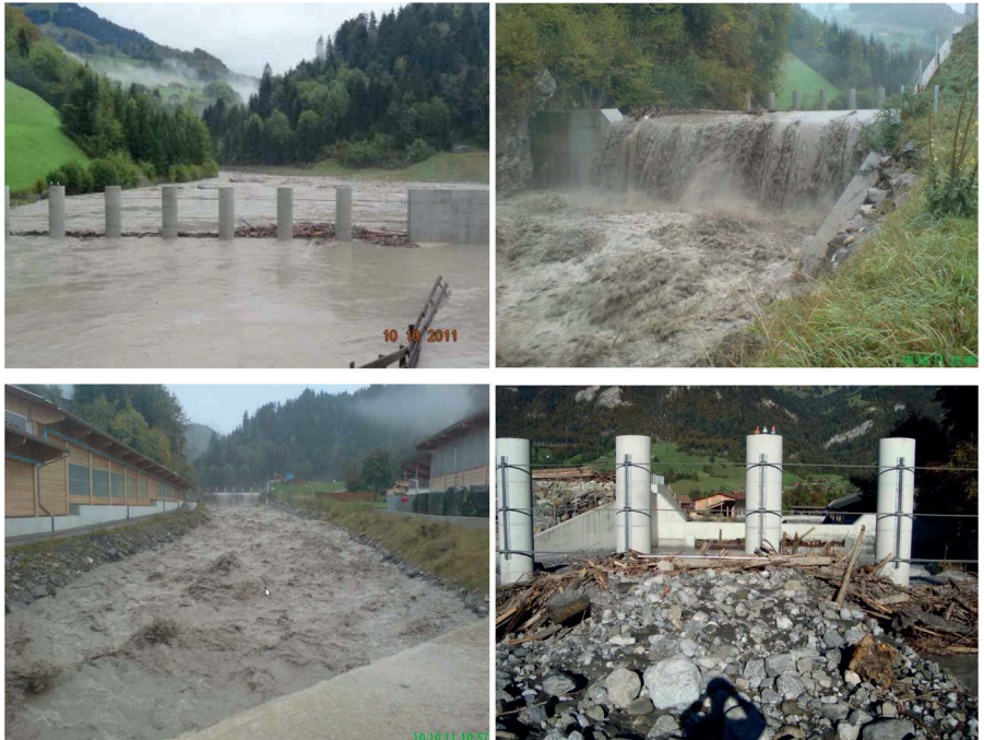
Abbildung 9: Fotos vom Hochwasser vom 10. Okt. 2011 (oben links) Schwemmholzrechen (oben rechts) Überfall Geschiebesperre (unten links) aufgeweitete Chiene oberhalb der Dorfbrücke (unten rechts) Geschiebe- und Schwemmholzablagerungen oberhalb des Rechen.
