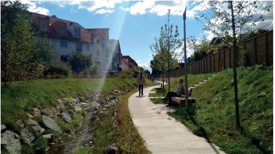
Abbildung 2: Petersbach Stadt Graz, Mittellauf nach Umsetzung der Hochwasserschutzmaßnahmen
