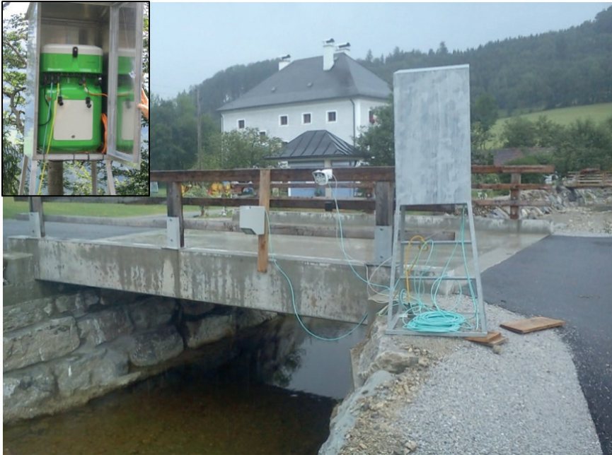
Abbildung 6: Mobiles Sicherheits-Einsatzsystem MOSES zur Baustellenabsicherung am Brunnbach
