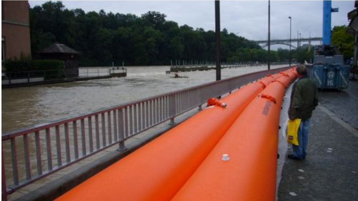
Fig. 2 Beaverschläuche als mobile Interventionsmassnahme im Mattequartier in Bern (Foto: Berufsfeuerwehr der Stadt Bern, 2007).
