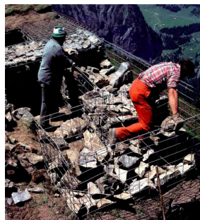
Fig. 8 Umbau von Steinmauern in Drahtsteinkörbe (Photo BLS)
