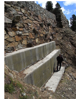
Fig. 7 Mit Betonvorbau sanierte Mauer (Photo S. Margreth)
