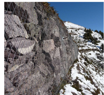
Fig. 9 Steinmauer mit rückverankertem TECCO-Drahtgeflecht (Photo M. Gächter)
