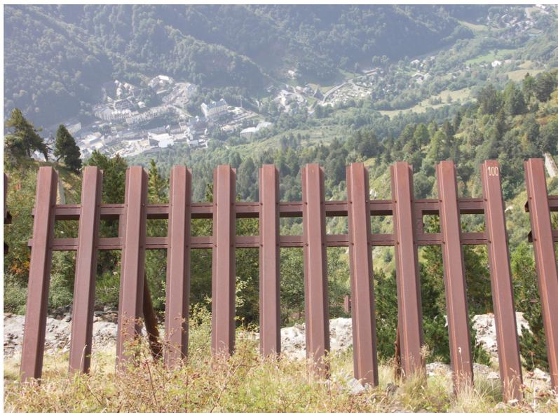
**Fig. 1** Dispositif de protection active contre les avalanches
