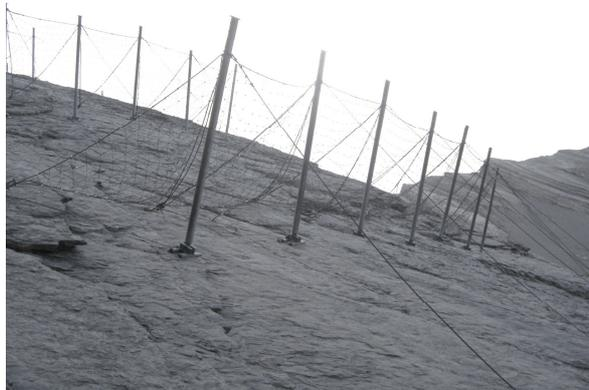
**Fig. 4** Filets paravalanches sur dalles inclinées
