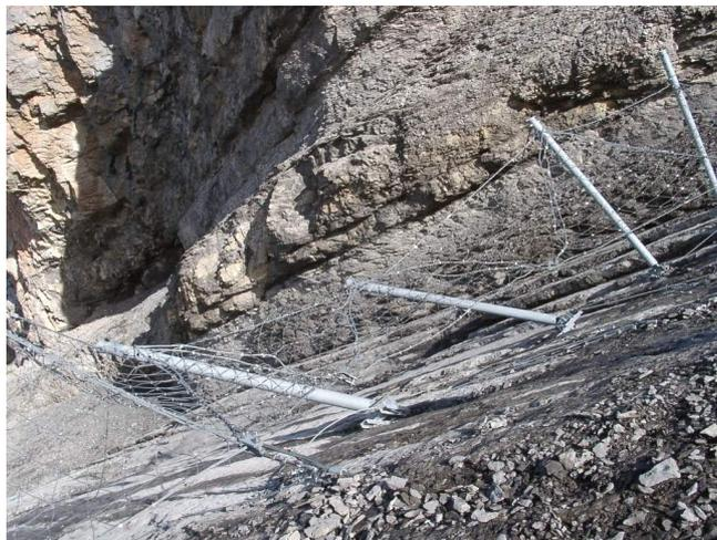
**Fig. 5** Rupture de la ligne amont du dispositif
