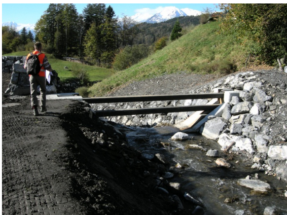
Fig. 17 Détail de l'aménagement d'une grille-seuil
