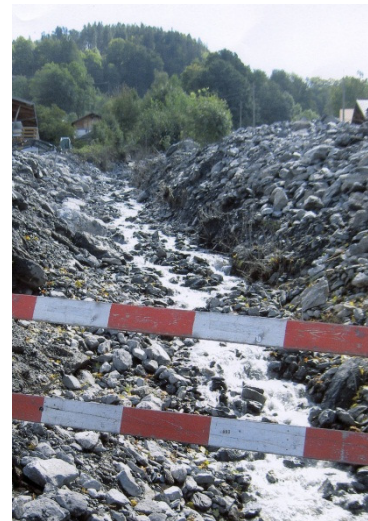
Fig. 2 Tronçon du Milibach à Reuti après la crue de 2005
