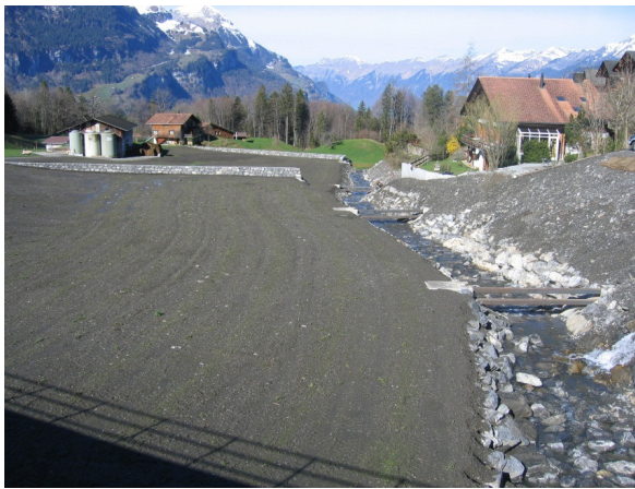
Fig. 15 Terrasses 2 et 3 en rive gauche du cours d'eau à la fin des travaux. Les épis de fermeture des terrasses et les grilles-seuils dans le lit sont visibles
