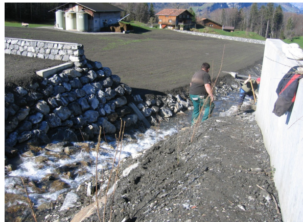
Fig. 18 Rampe en blocs entre les terrasses 2 et 3
