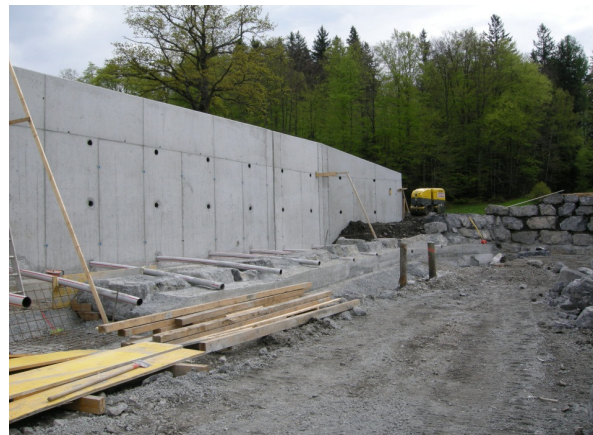
Fig. 16 Mur de soutènement entre les terrasses, vue d'aval
