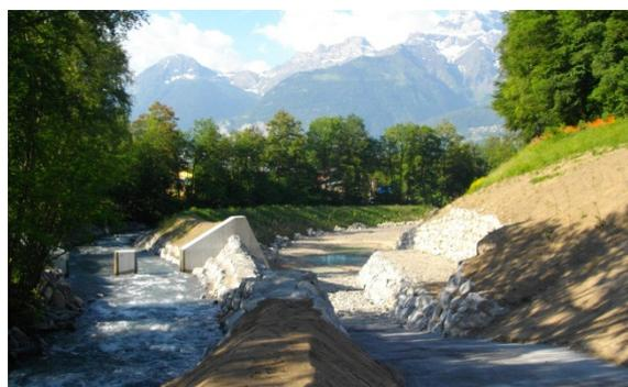
**Fig. 18** Vue amont du seuil à engravures (à gauche) et de la zone d'épandage (à droite)
