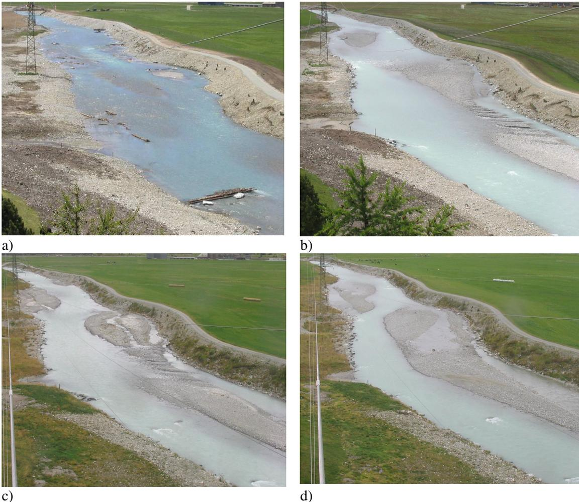
**Fig. 3** Entwicklung der Aufweitung von 2004 -2008, Webcam-Aufnahmen, Blick flussaufwärts, Abfluss jeweils  $Q = 10 \text{ m}^3/\text{s}$ : (a) Juni 2004, vor HW'04; (b) Juli 2004, nach HW'04; (c) August 2007; (d) September 2008, nach einem  $HQ_5$
