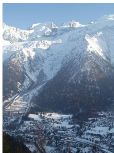
Fig. 4 Tacconnaz avalanche path Fig. 4 Couloir d'avalanche de Tacconnaz
