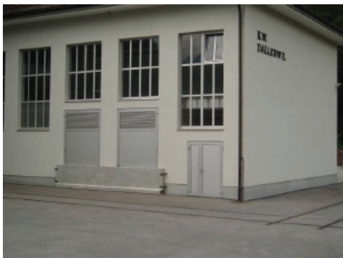
Abb. 6: Objektschutzmassnahmen am Wasserkraftwerk Dallenwil (Foto: Nidwaldner Sachversicherung)
