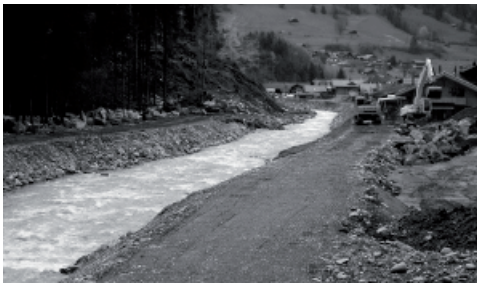
Abb. 9: Hochwasserschutzdamm als Sofortmaßnahme zum Schutz des Dorfes Oey.
