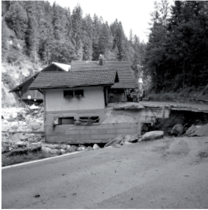
Abb. 7: Durch Gerinneverlagerung beschädigtes Gebäude und zerstörte Talstraße.
