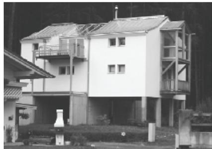
**Abb. 2:** Erhöhte Anordnung von Gebäuden mittels aufgeständerter Bauweise (Bild: Fuchs, 2007).
