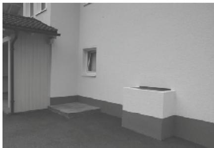
**Abb. 3:** Verhinderung von Eintritt von Wasser und Feststoffen durch über das Flutniveau gezogene Kellerlichtschächte.
