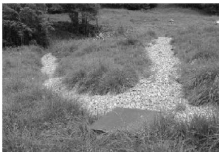
**Abb. 8:** Drainage zur Entwässerung instabiler Schichten.
