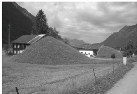
**Abb. 12:** Ablenkdämme und Spaltkeile.
