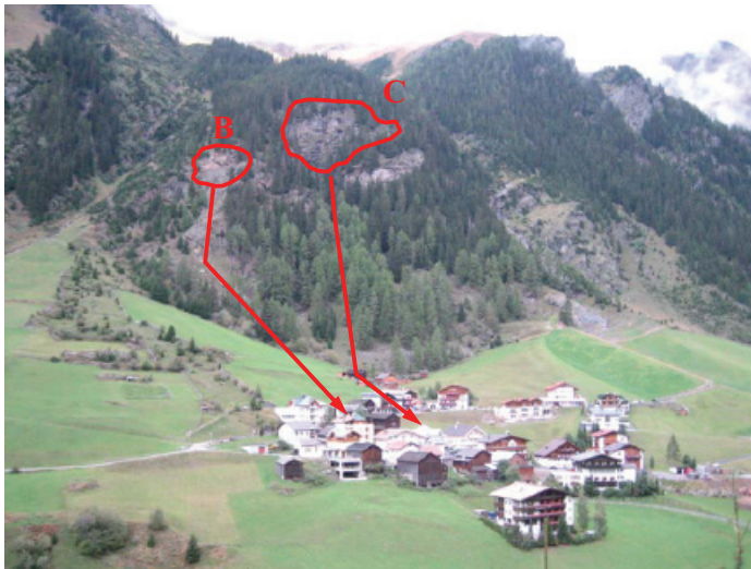
Fig. 5: Overview of investigated area Versahl (B+C) with potential detachment zones and pathway Abb. 5 Überblick über untersuchten Bereich Versahl (B+C) mit potentiellen Ablösebereichen und Sturzbahn
