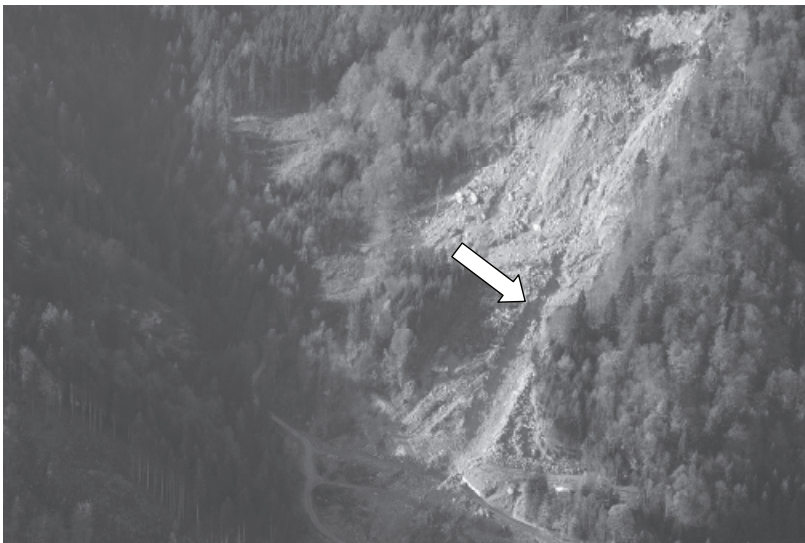
Abb. 8: Überblick über die gesamte Rutschung. Unterhalb der Verebnung ist die Ableitrinne zu erkennen Fig. 8: Overview of the whole landslide. Under the plain the drain channel can be seen
