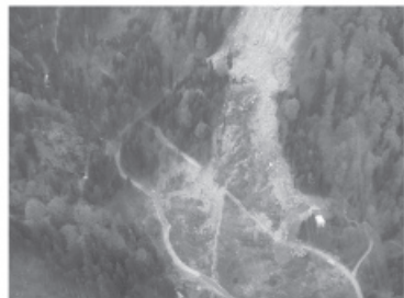
Abb. 5: Unterer Bereich der Hangbewegung. Fig. 5: Lower part of the landslide
