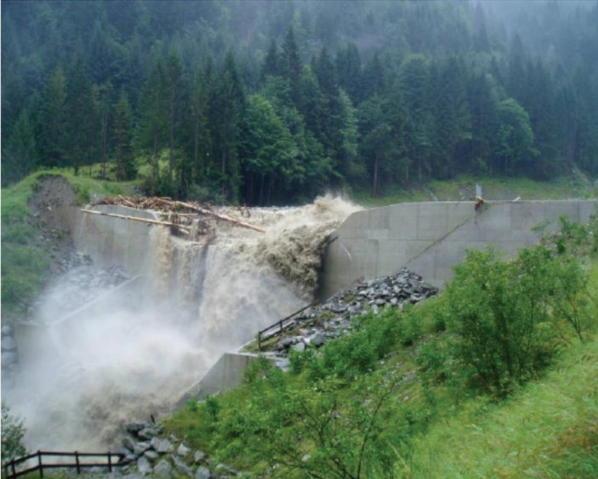
**Abb2:** Geschiebestausperre während dem Hochwasserereignis aus dem Jahre 2005
