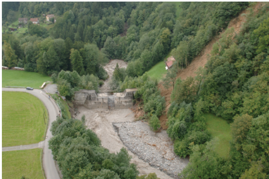
Abb. 2: Der Geschiebesammler 'Stiglisbrücke' am Schächen; Blick in Fließrichtung auf das Abschlussbauwerk (Foto vom 23.08.2005, © Tiefbauamt Uri)
