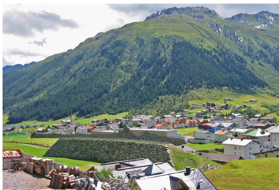
Galtür avalanche dam. Credits: S. Fuchs
