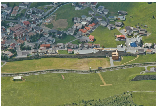
Galtür avalanche dam. Credits: J. Hübl
