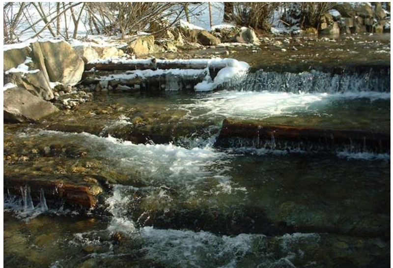
Foto 7: Rampe nach Umbau in eine aufgelöste Kaskadenschwelle (Untersuchungsstelle 5)
