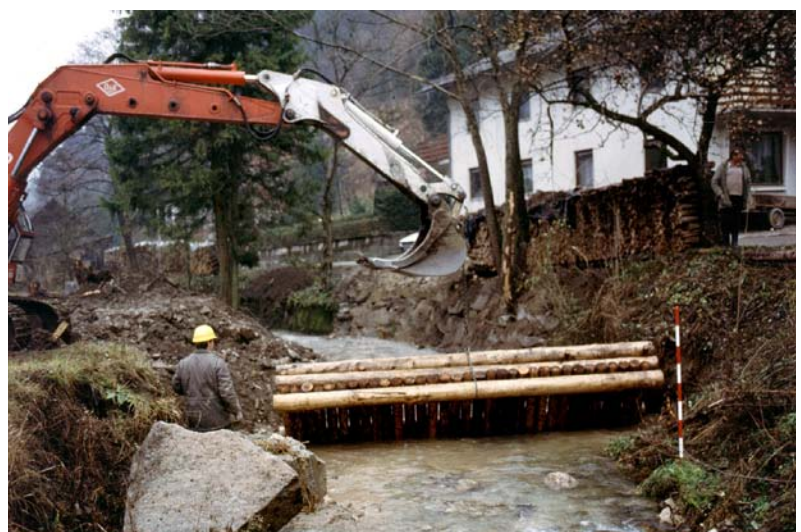
Foto 2: Einbau der ökologischen Steinkastenschwelle
