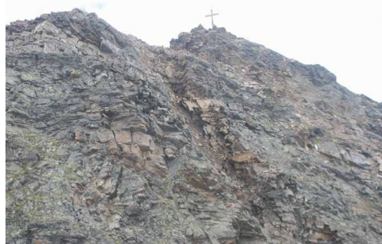
Solco generato da un crollo di roccia. Foto: V. Mair
