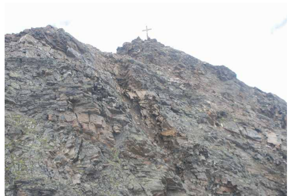
Abbruchfläche eines Felssturzes. Foto: V. Mair
