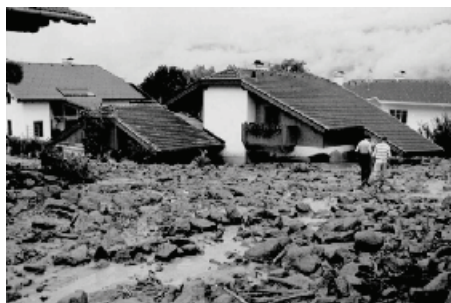
Abb. 3: Schäden in der Wartschensiedlung aufgrund des Ereignisses vom 16.08.1996. Fig. 3: Damage caused by the event of August 16, 1996 on the fan of Wartschenbach test site.
