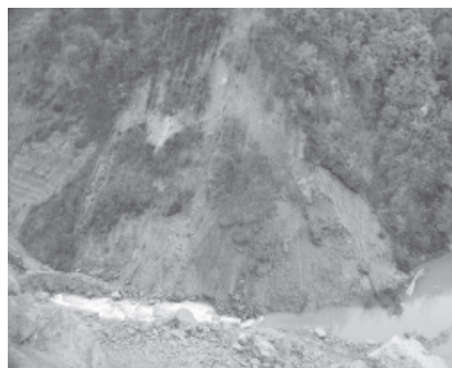
Fig. 4: Frana rototraslativa in destra Savena
