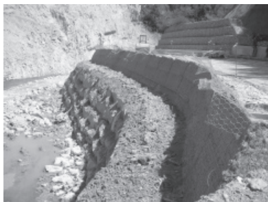
Fig. 13: intervento di ripristino stradale Fig. 13: reconstructed road embankment
