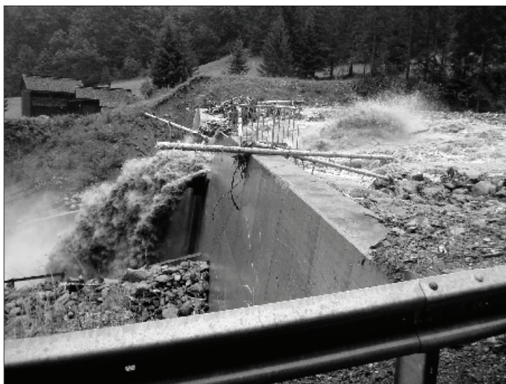
Abb. 1: Hochwasserereignis am Suggadinbach im Montafon in Vorarlberg im August 2005 (Quelle: WL.V Bludenz)
