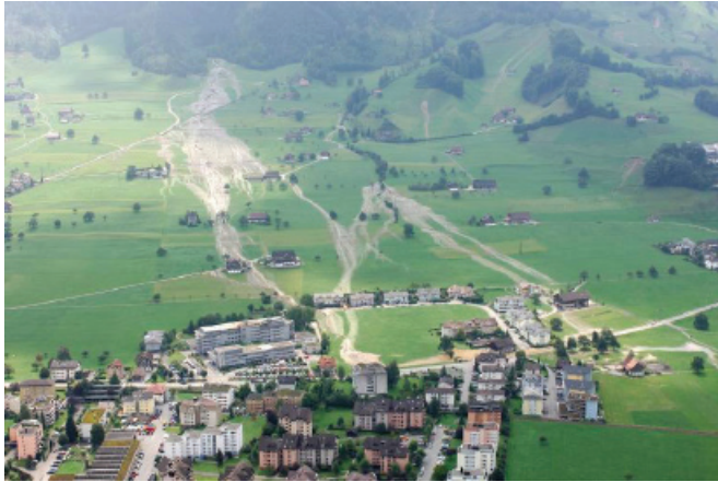
Abb. 5: Spital Stans und Überschwemmung durch Oberflächenwasser (Foto: Kanton Nidwalden).
