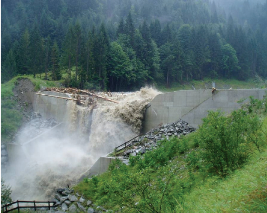
Abb2: Geschiebestausperre während dem Hochwasserereignis aus dem Jahre 2005
