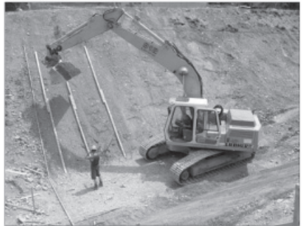
Abb. 8: Aushub für neues Abflussprofil Fig. 8: excavation for new cross section
