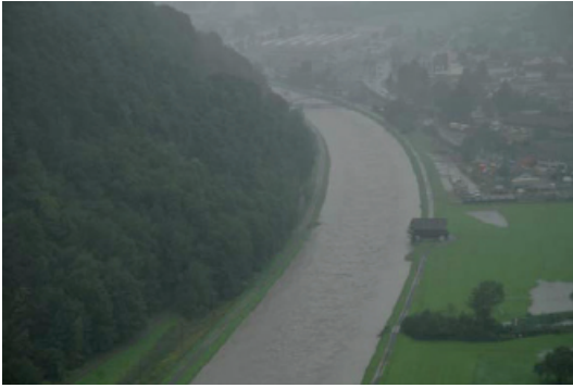
Abb. 4: Escherkanal, Hochwasserereignis August 2005 (ca. 7 Std. nach dem Durchgang der Hochwasserspitze). Fig. 4: Canal Escher, Flood event August, 2005 (approx. 7 hrs after the flood peak).
