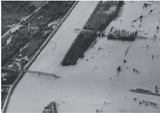
Abb. 12: Beispiel eines Dammbrechens am Alpenrhein beim Hochwasser 1927. Weil der Damm brach, floss praktisch der ganze Alpenrhein aus.
