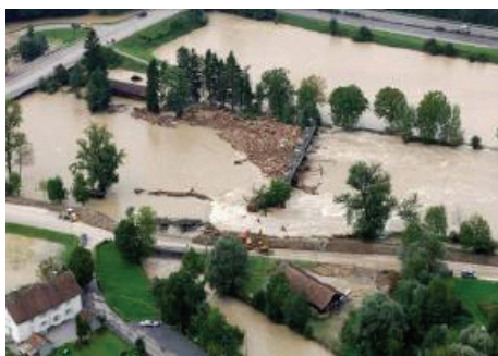
Abb3: Wehr bei Perlen mit Schwemmholz (2005)
