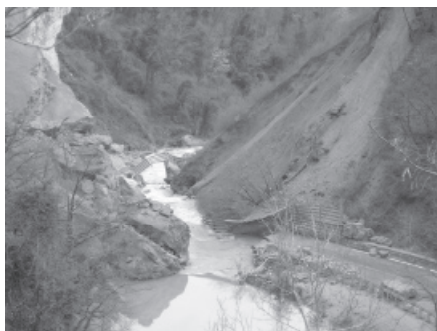
Fig. 5: Strada fondovalle Savena a ottobre 2005
