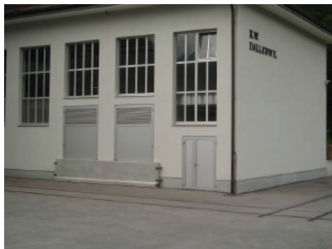
Abb. 6: Objektschutzmassnahmen am Wasserkraftwerk Dallenwil (Foto: Nidwaldner Sachversicherung)
