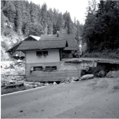
Abb. 7: Durch Gerinneverlagerung beschädigtes Gebäude und zerstörte Talstraße.
