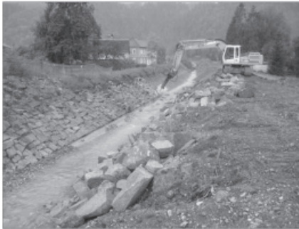
Abb. 7: Abbruch bestehende Ortsstrecke Fig. 7: demolition of the existing lined canal
