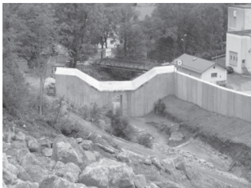
Abb. 9: Blick von Süden nach Norden auf die Schlitzsperre, die südlich von Immenstadt erbaut wurde Fig. 9: Photo in view of the open debris retention dam in the south of Immenstadt
