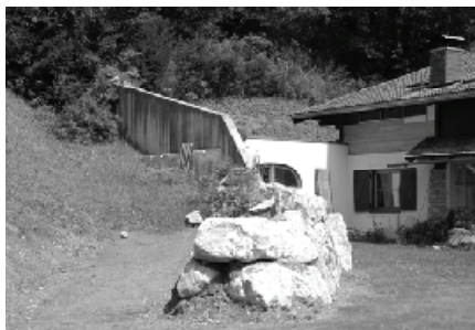
Abb. 6: Ablenkmauer bzw. -damm. Fig. 6: Deflection wall and dam.
