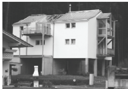
Abb. 2: Erhöhte Anordnung von Gebäuden mittels aufgeständerte Bauweise (Bild: Fuchs, 2007).
