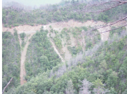
Abb. 12: Abrutschung talseitiger Strassenböschungen Fig. 12: Sliding of the road embankment
