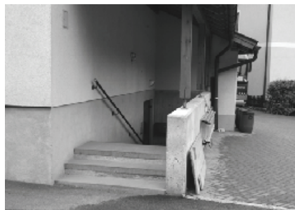
Abb. 4: Verhinderung von Eintritt von Wasser und Feststoffen durch über das Flutniveau gezogene Kellerabgänge.
