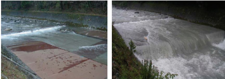
Abb. 3, 4: Abflussmessstation Schächen-Bürglen mit dem Pneumatikmessprofil und der Vorschwelle bei Niedrigwasserabfluss (Bild links) und bei einem kleineren Hochwasser (Bild rechts).
