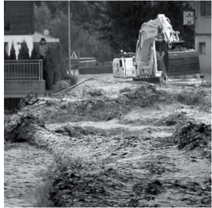
Abb.8: Überflutung mit hoher Intensität in Oey.
