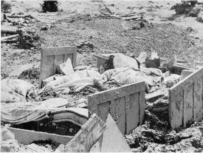
November 1966. In Flattach. Das blieb von einem Haus . . .
