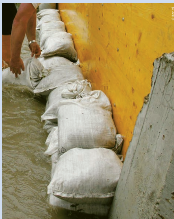
Beispiel: Sandsäcke als mobiles Schutzelement
