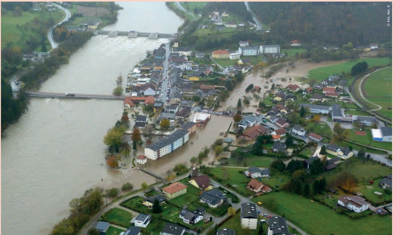
Beispiel: Hochwasser an Drau und Lavant (Bereich Lavamünd)
