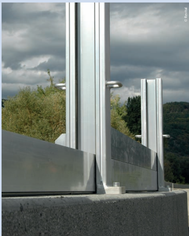
Beispiel: Mobile Hochwasserschutzwand
