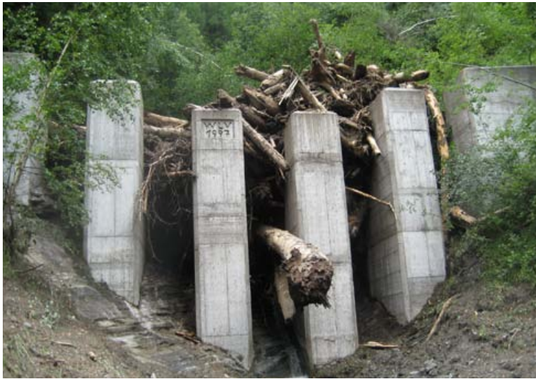
Wildholzsperr im Kreuzgraben (Foto: WLV Salzburg)
