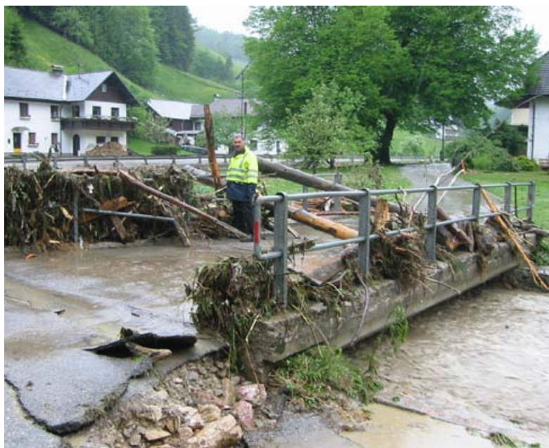
Verklausung am Laussabach, Oberösterreich, Hochwasser 2005 (Foto: Freiwillige Feuerwehr Laussa)
