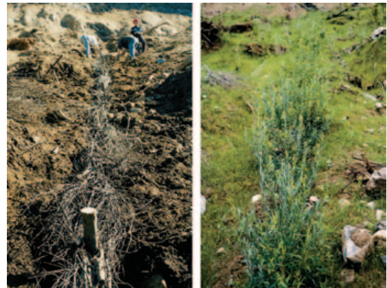
Weidenfaschinen: Einbau bzw. nach Fertigstellung (Foto: BOKU)
