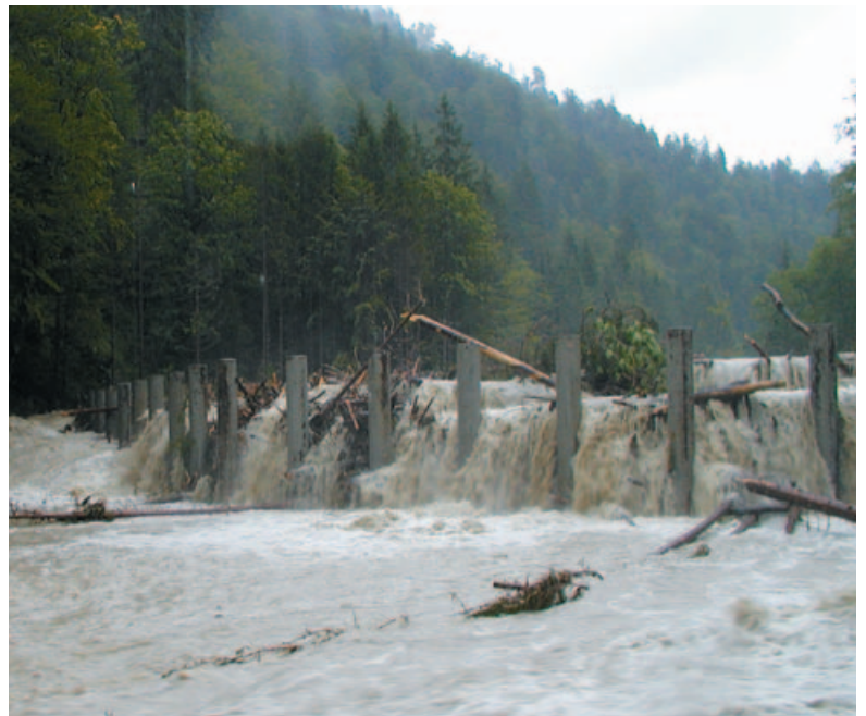
Wildholzrechen an der Pöllat in Schwangau, Bayern (Foto: Wasserwirtschaftsamt Kempten)
